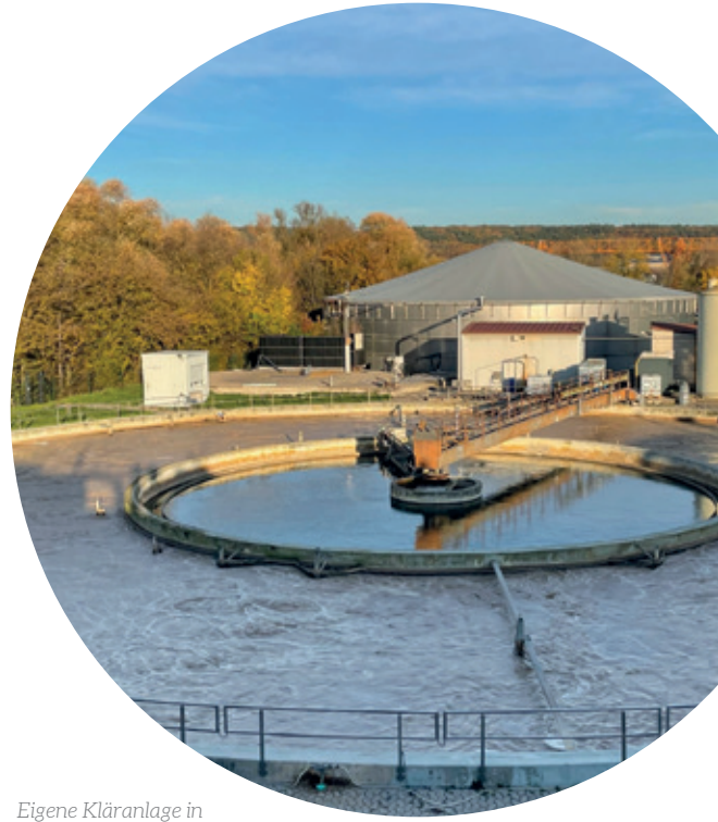
Eigene Kläranlage in Zapfendorf
